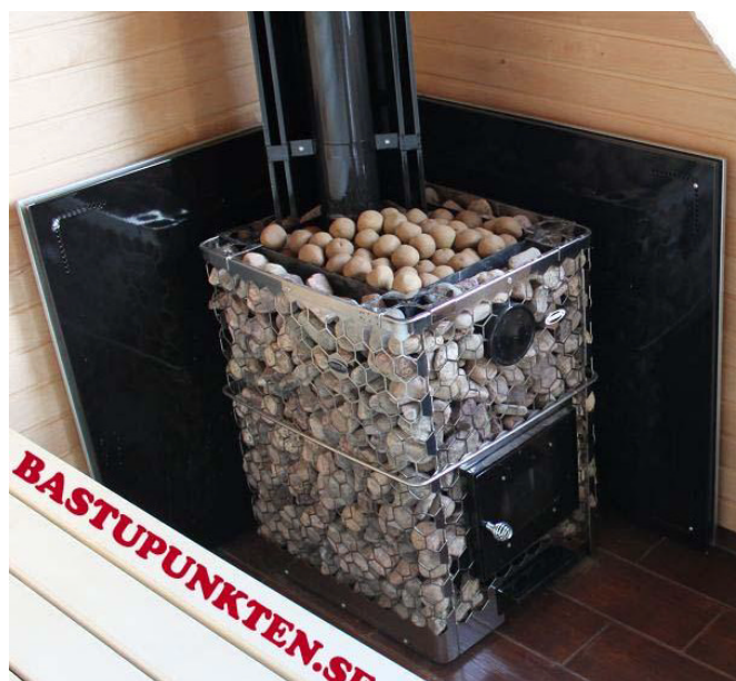
Kiviset med det yttre stenmagasinet fyllt med granit och det inre med keramisk bastusten, ett tunnt lager granit läggs sen överst.
