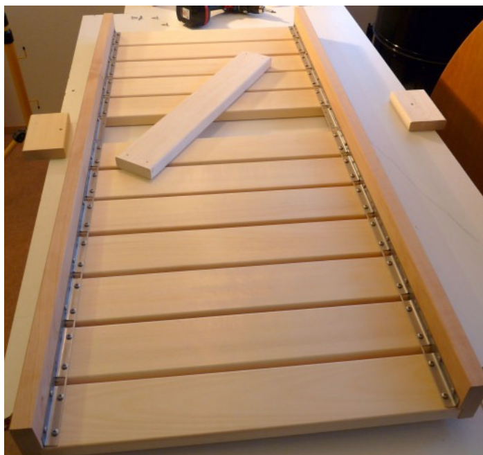
Montering på frontbrädor med hyvlade urtag
